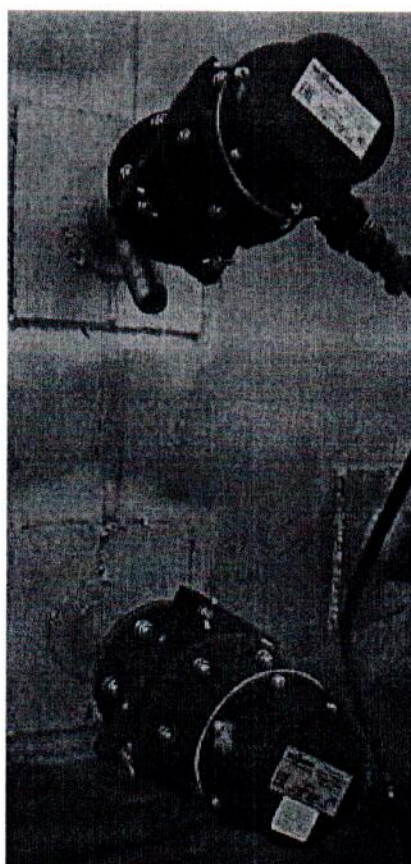
Рисунок 1.5 – Фотография измерителя расхода и скорости газового потока. Система автоматизированного контроля и учета за выбросами загрязняющих веществ в атмосферный воздух от нагревательной печи стана 320 СПЦ-1 ОАО «БМЗ - управляющая компания холдинга «БМК» № СЭ.20132.АСК.УХЛ1
