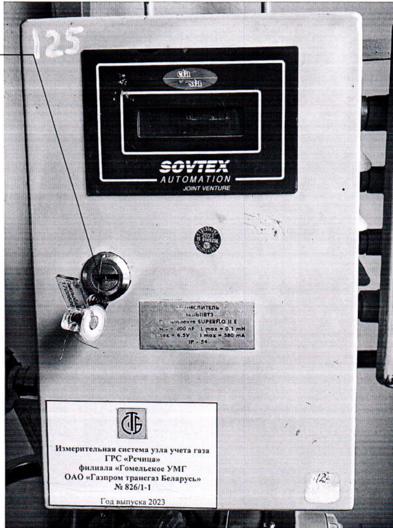
Рисунок 3.1 – Схема пломбировки от несанкционированного доступа
