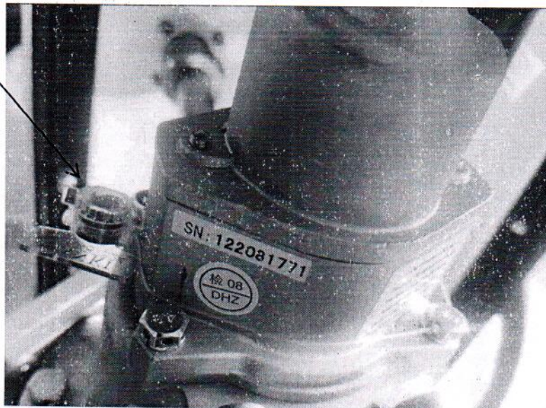
Рисунок 3.3 – Схема пломбировки от несанкционированного доступа датчика импульсов НВМQ-7А
