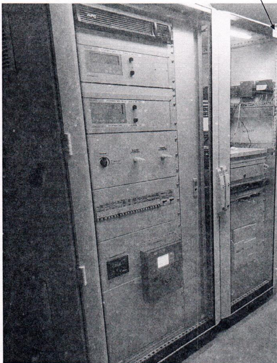
Фотография 8 – Шкаф газового анализа и сервера АСКВ с маркировочной табличкой
