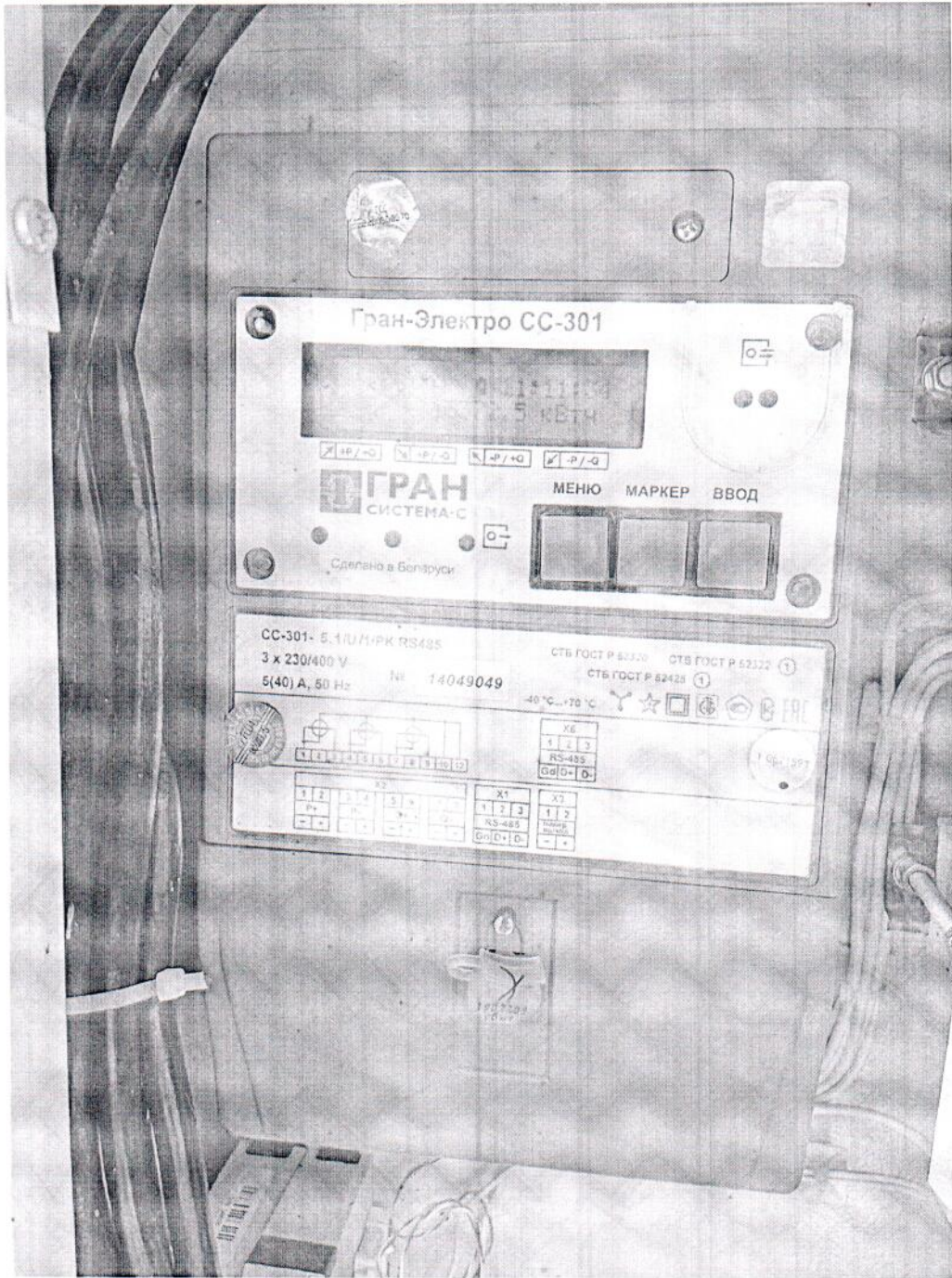
Рисунок 1.2 – Фотография общего вида счетчика электрической энергии
