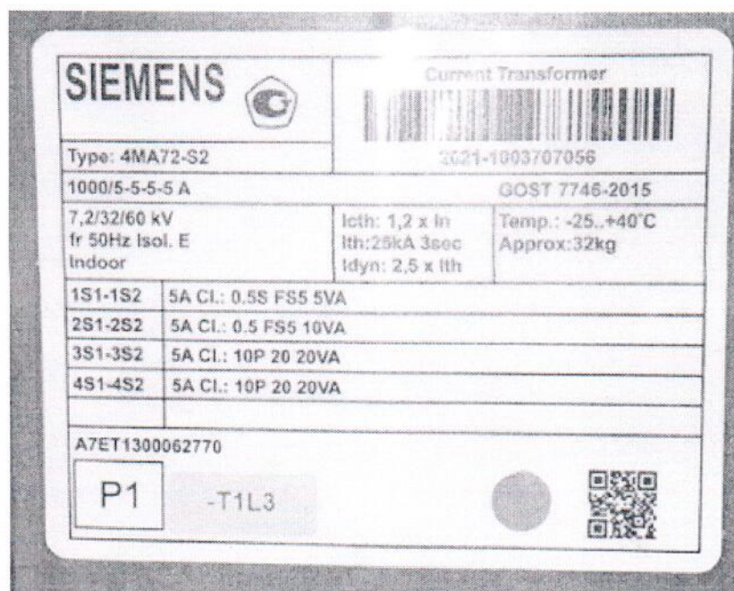
Рисунок 1.2 – Фотография маркировки трансформатора тока 4MA72-S2 АУС № 1003707056
