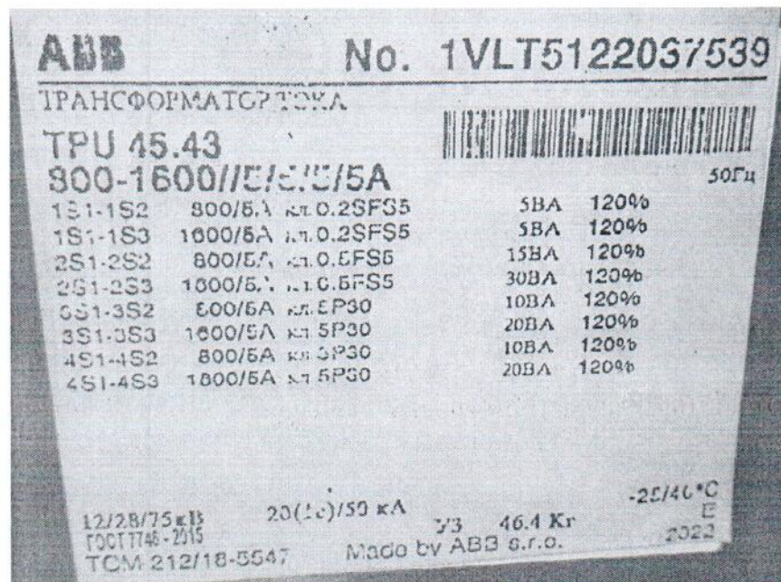
Рисунок 1.2 – Фотография маркировки трансформатора тока TPU 45.43 № 1VLT5122037539
