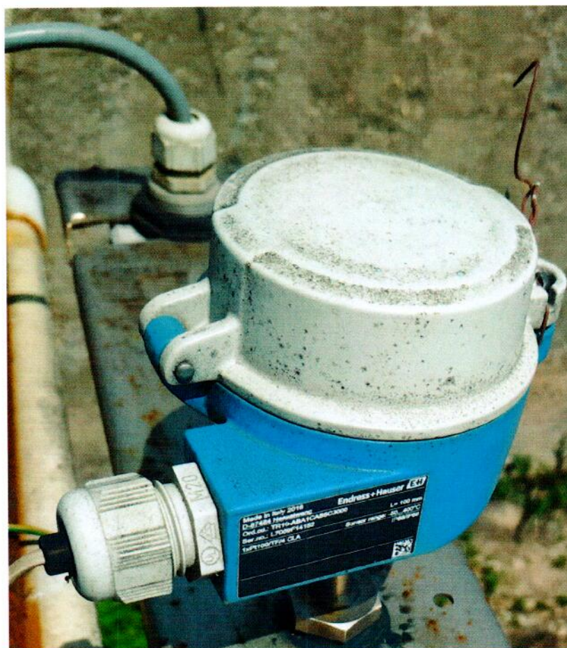
Рисунок 1.5 – Фотография общего вида термопреобразователя сопротивления Omnigrad TR10-ABA1CAS5C3000 № L7069F14152 входящего в состав узла учета (основной комплект)
