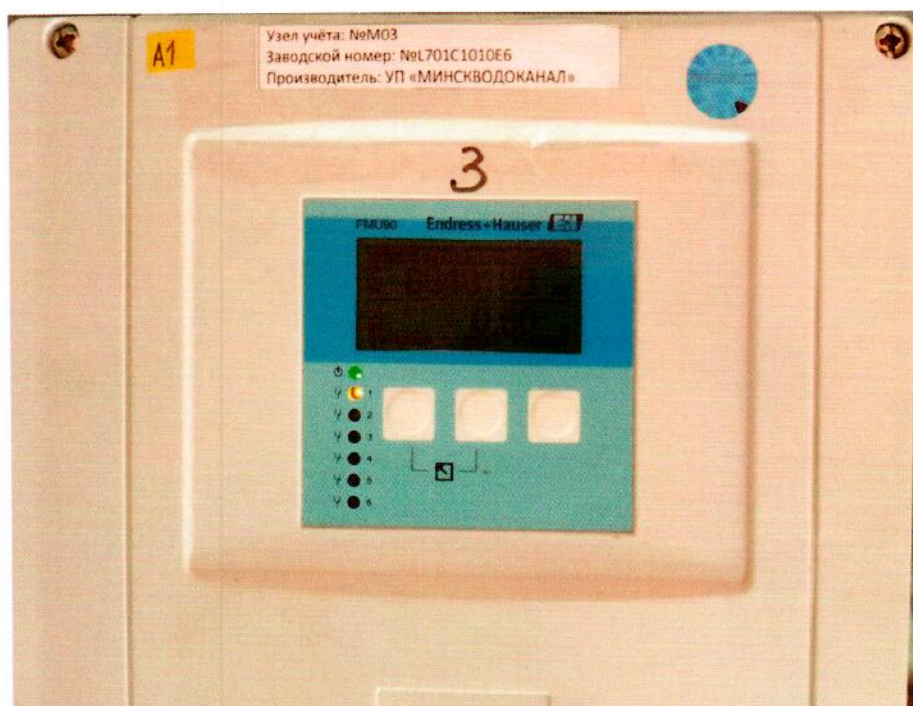
Рисунок 1.1 – Фотография общего вида вторичного преобразователя FMU90-R21CA113BA2A № L701C1010E6 уровнемера ультразвукового PROSONIC входящего в состав узла учета (основной комплект)
