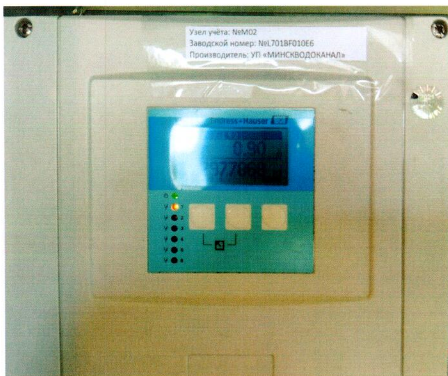
Рисунок 1.1 – Фотография общего вида вторичного преобразователя FMU90-R21CA113BA2A № L701BF010E6 уровнемера ультразвукового PROSONIC входящего в состав узла учета (основной комплект)
