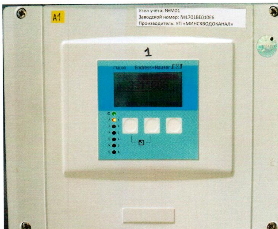
Рисунок 1.1 – Фотография общего вида вторичного преобразователя FMU90-R21CA113BA2A № L701BE010E6 уровнемера ультразвукового PROSONIC входящего в состав узла учета (основной комплект)
