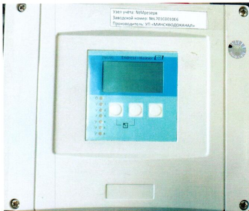
Рисунок 1.7 – Фотография общего вида вторичного преобразователя FMU90-R21CA113BA2A № L701C0010E6 уровнемера ультразвукового PROSONIC входящего в состав узла учета (резервный комплект)
