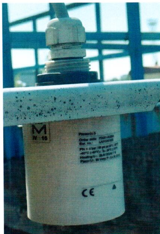
Рисунок 1.3 – Фотография общего вида первичного преобразователя FDU91-RG3BA № LA012A010E8 уровнемера ультразвукового PROSONIC входящего в состав узла учета (основной комплект)
