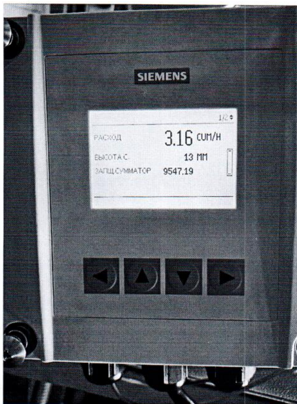
Рисунок 1.1 – Фотография общего вида уровнемера ультразвукового SITRANS LUT 440 № PBD/N3010016 входящего в состав узла учета
