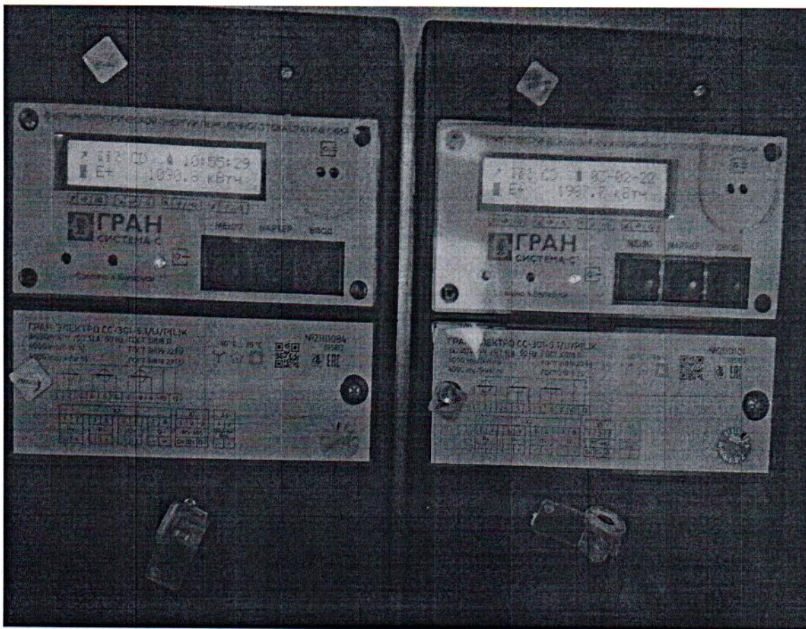
Рисунок 2 – Фотография компонентов АСКУЭ при применении счетчиков электрической энергии «Гран-Электро СС-301».
