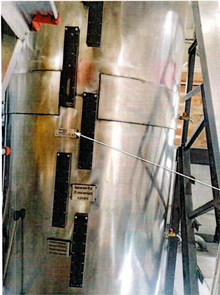
Рисунок 2 – Указание места для нанесения знака поверки мерника технического 1-го класса М1кл-2500 № 10
