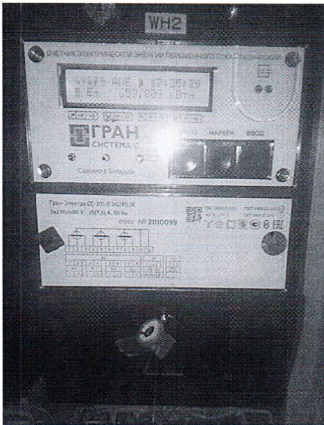
Рисунок 2 – Фотография компонентов АСКУЭ при применении счетчика электрической энергии «Гран-Электрос СС-301» и «Гран-Электрос СС-101»
