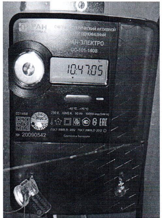
Рисунок 2 – Фотография компонентов АСКУЭ при применении счетчика электрической энергии «Гран-Электрос СС-301» и «Гран-Электрос СС-101»
