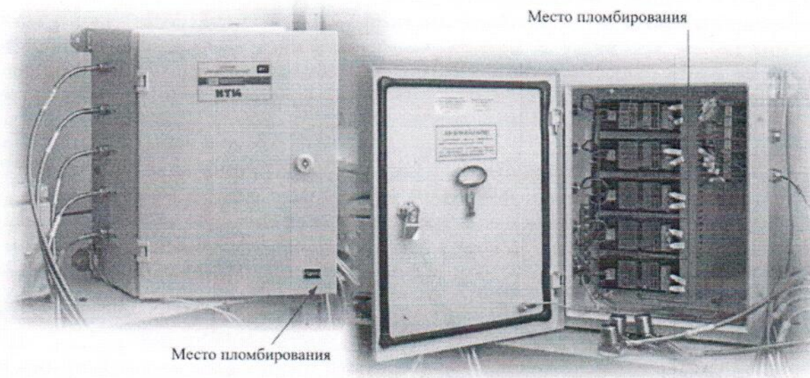
Рисунок 1 – Шкафы с измерительными преобразователями
