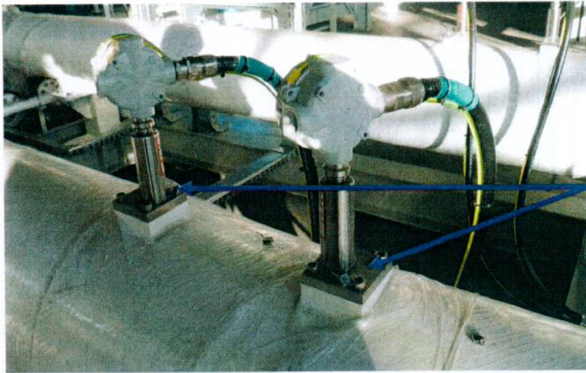
Рисунок 4 - Места пломбирования ТПУ OGSB
