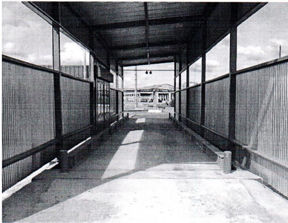
Рисунок 3 – Внешний вид весов, установленных в приямок
