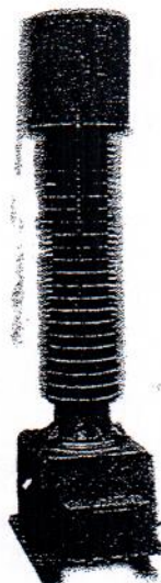
Трансформатор напряжения НАМИ-110
