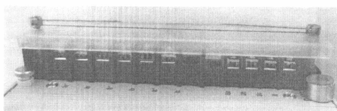
Рисунок 9. Пломбировка клеммных соединителей измерительных цепей
